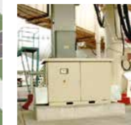
times-top Solid State converter APOJET AJS.
